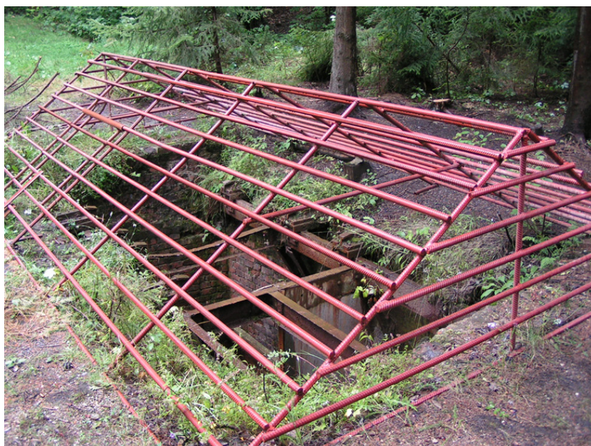
Rys. 12. Wlot szybu „Louis” (nr 2) zabezpieczony klatką – stan obecny
